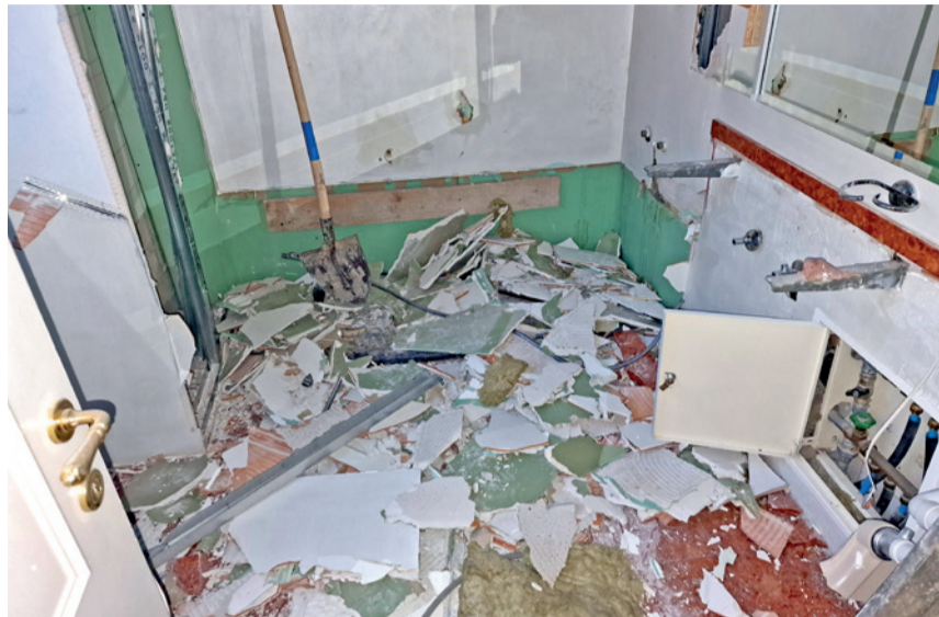
Alles muss raus: Badezimmerumbau in vollem Gange.
